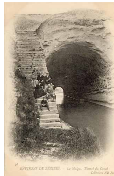
Le tunnel du Malpas, objet de curiosité de la part de non-usagers du canal.
