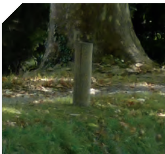
▲ Des bollards en simples rondins de 18 cm de diamètre pour la manœuvre d'appontement
