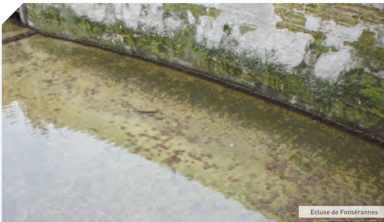
▲ Le sol de pierres appareillées du sas de l'écluse.
