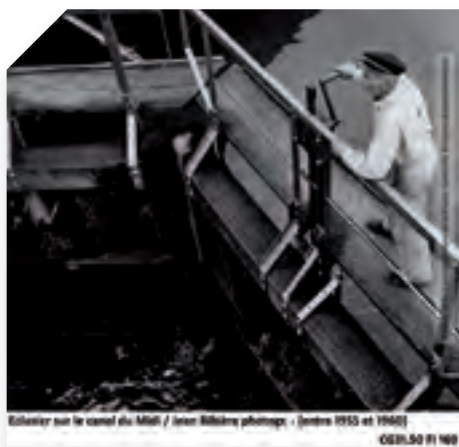
▲ Le marinier manœuvre le cric de vantelle sur une porte de bois.
