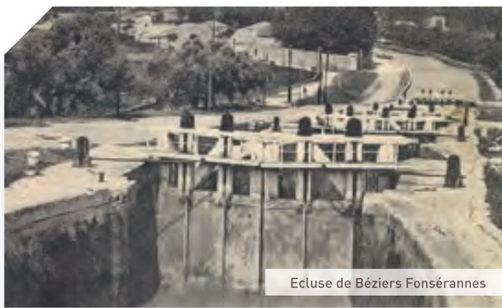
▲ En 1915, portes de bois manœuvrées par des crics à manivelle.
