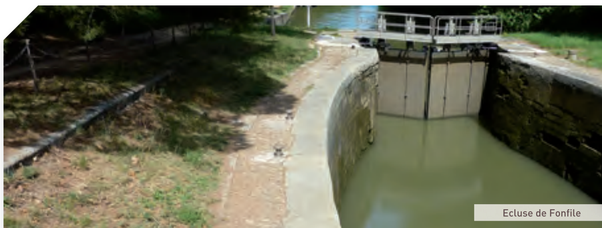
▲ Le talus de raccord est enherbé, limité franchement par la bordure de pierre du sol de bajoyer
