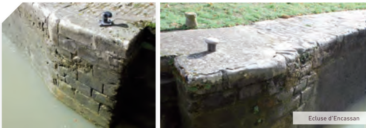
▲ Les pierres sont usées par les chocs et frottements à l'entrée des portes.
