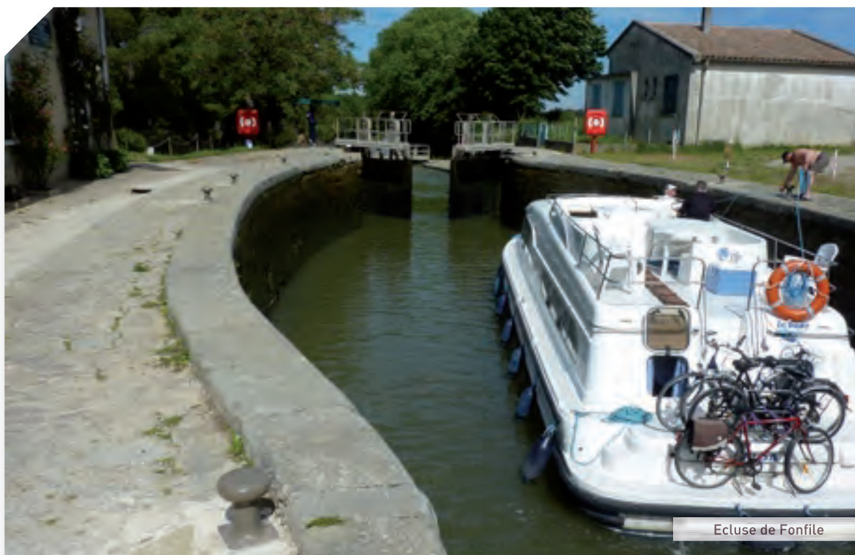
▲ Deux sols durs différents de mortier font la jonction depuis le sol de pierre du bajoyer avec la maison. Le bord du bajoyer a été légèrement surélevé pour permettre d'augmenter le tirant d'eau dans le bief amont.
