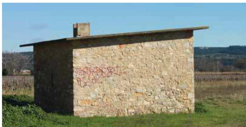
Un mazet dénaturé par sa toiture béton.
