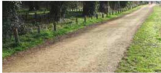
Revêtement stabilisé à liant hydraulique similaire à celui retenu pour la vélo-route du canal des 2 Mers, avec un rendu proche de celui des chemins de halage
