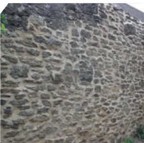
▲ Joints à pierres vues
