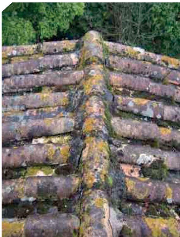
▲ Couverture en tuiles canal avec faîtières scellées
