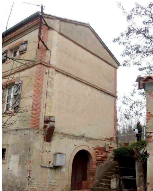
▲ Exemples d'utilisations de la brique de parement ( chaînage vertical et encadrements ) et en remplissage
