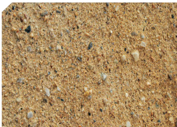
▲ Enduit à pierres lavées
