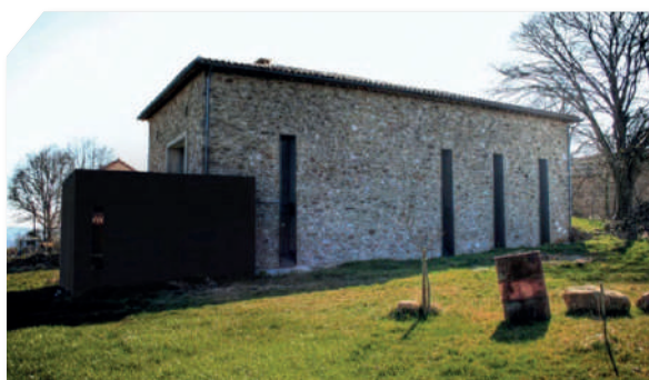
▲ Transformation d'une grange en habitation 2005 (82). Nicolas San, Frédéric Rivière
