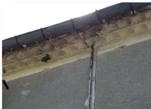
▲ Génoise sur un mur gouttereau
