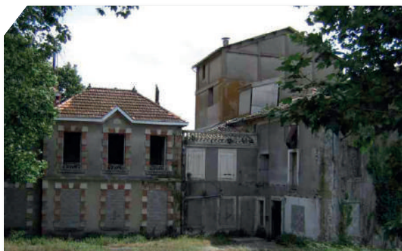
▲ Exemples de modénatures (minoterie de Trèbes)
