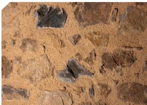
▲ Enduit à pierres vues
