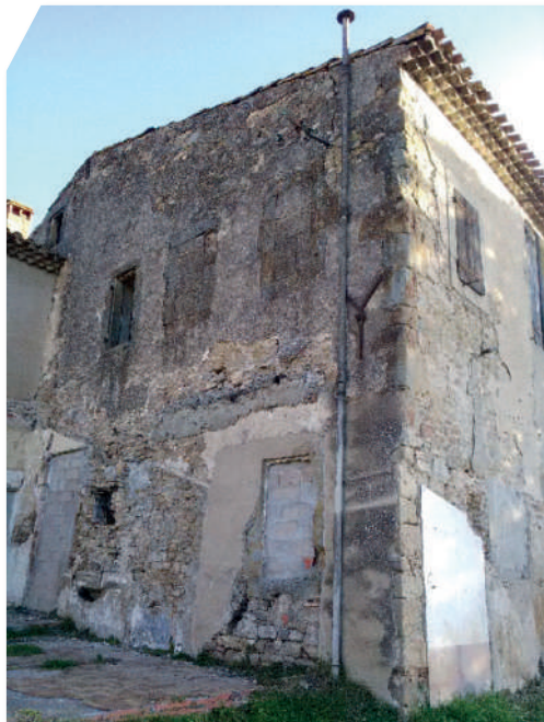
▲ Exemples de maçonnerie en moellons visibles sur le canal
