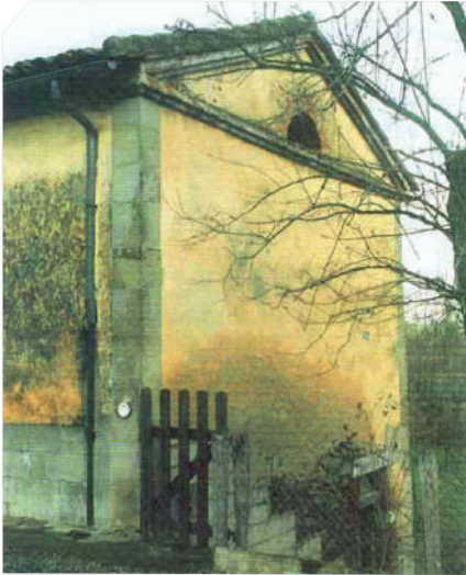
▲ Exemple de désordres causé par l'humidité
