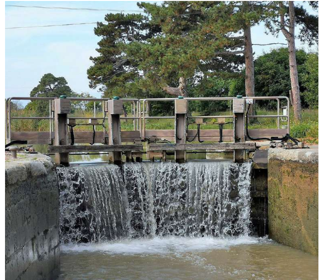
Portes amont de l'écluse d'Ognon
