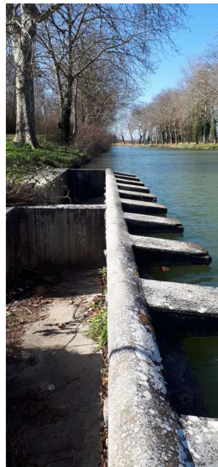
Lavoir du bief de Villepinte VNF
