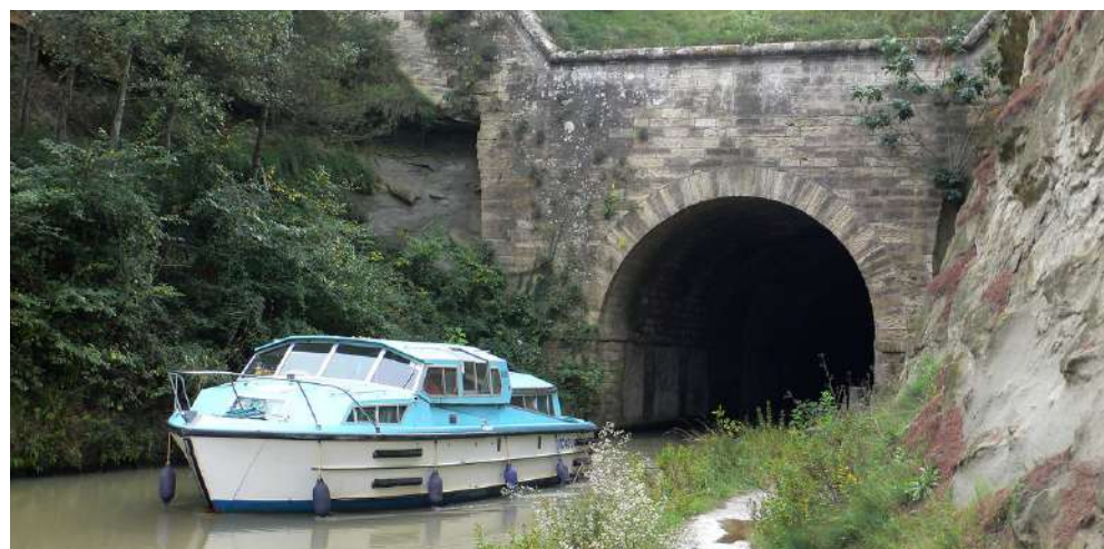
Bateau sortant du tunnel du Malpas
