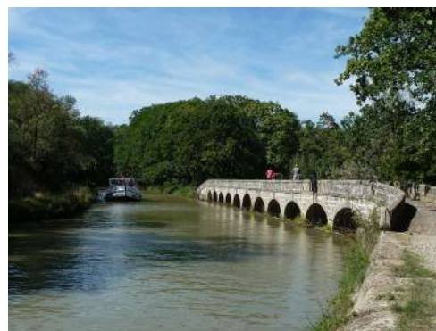
L'aqueduc de l'Argent-Double
