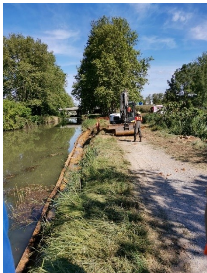
Travaux par madriers jointifs ©VNF
