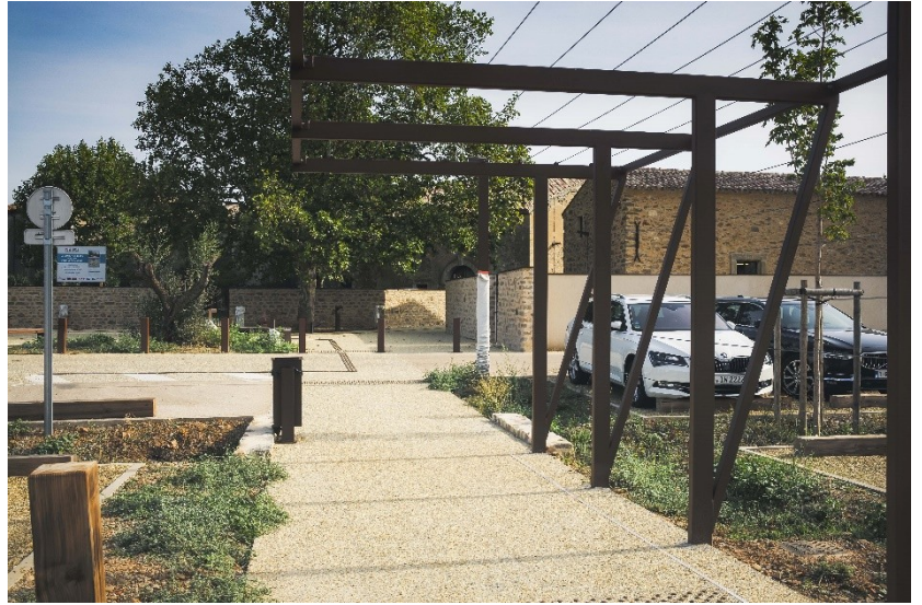
Aménagements réalisés ©Grand Narbonne
