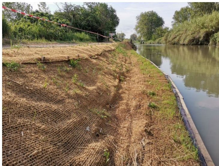
Travaux de végétalisation ©VNF
