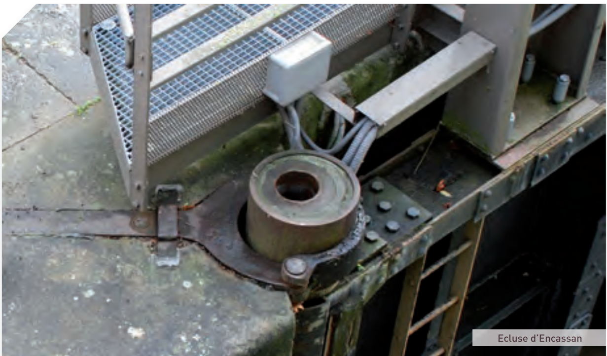
▲ Le scellement au plomb de l'axe de la porte dans le cylindre de maintien permet son réglage fin en place.
