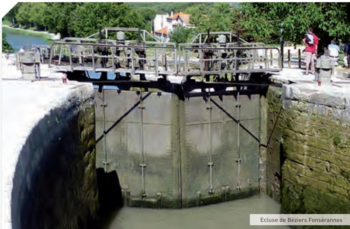
▲ Porte métallique motorisée : un moteur actionne simultanément les crics des deux vantelles du vantail. Sur le bajoyer un moteur actionne le cric de crémaillère et l'ouverture du vantail.
