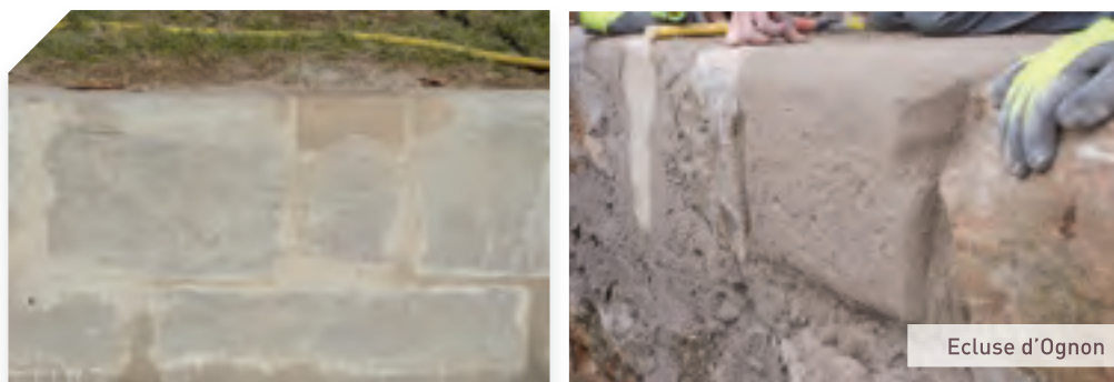
▲ Un mortier de réparation pour une pierre cassée ou pour le remplacement provisoire d'une pierre entière.
