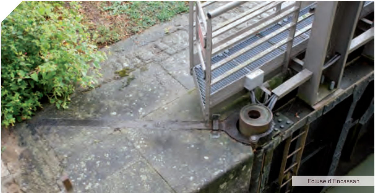
▲ La longue tige d'acier maintient la tête de l'axe de la porte.
