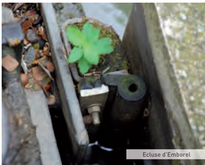
▲ La bande d'étanchéité d'une porte récente, en caoutchouc, prend appui sur la pierre de chardonnet.
