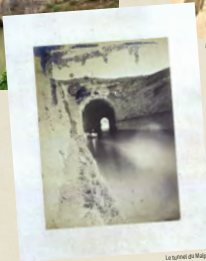
Le tunnel du Malpas
