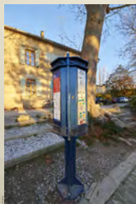
Photo de commande pour effectuer la sortie (passage de l'écluse)
