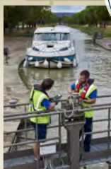
Optimisation de maintenance électrique à l'écluse de Soubou.
