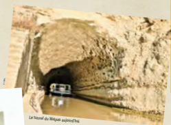
Le tunnel du Malpas aqueduc
