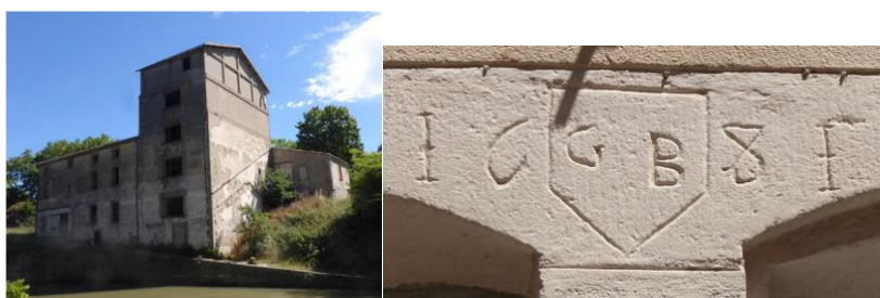
Le port de Trèbes, un ancien lieu actif du canal se lisant dans le paysage urbain et dans la pierre. La minoterie, une maison portant la date de 1688, soit 7 ans après l'inauguration du canal
