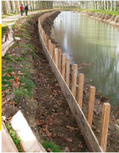
© VNF, Travaux de berges en vidange partielle
