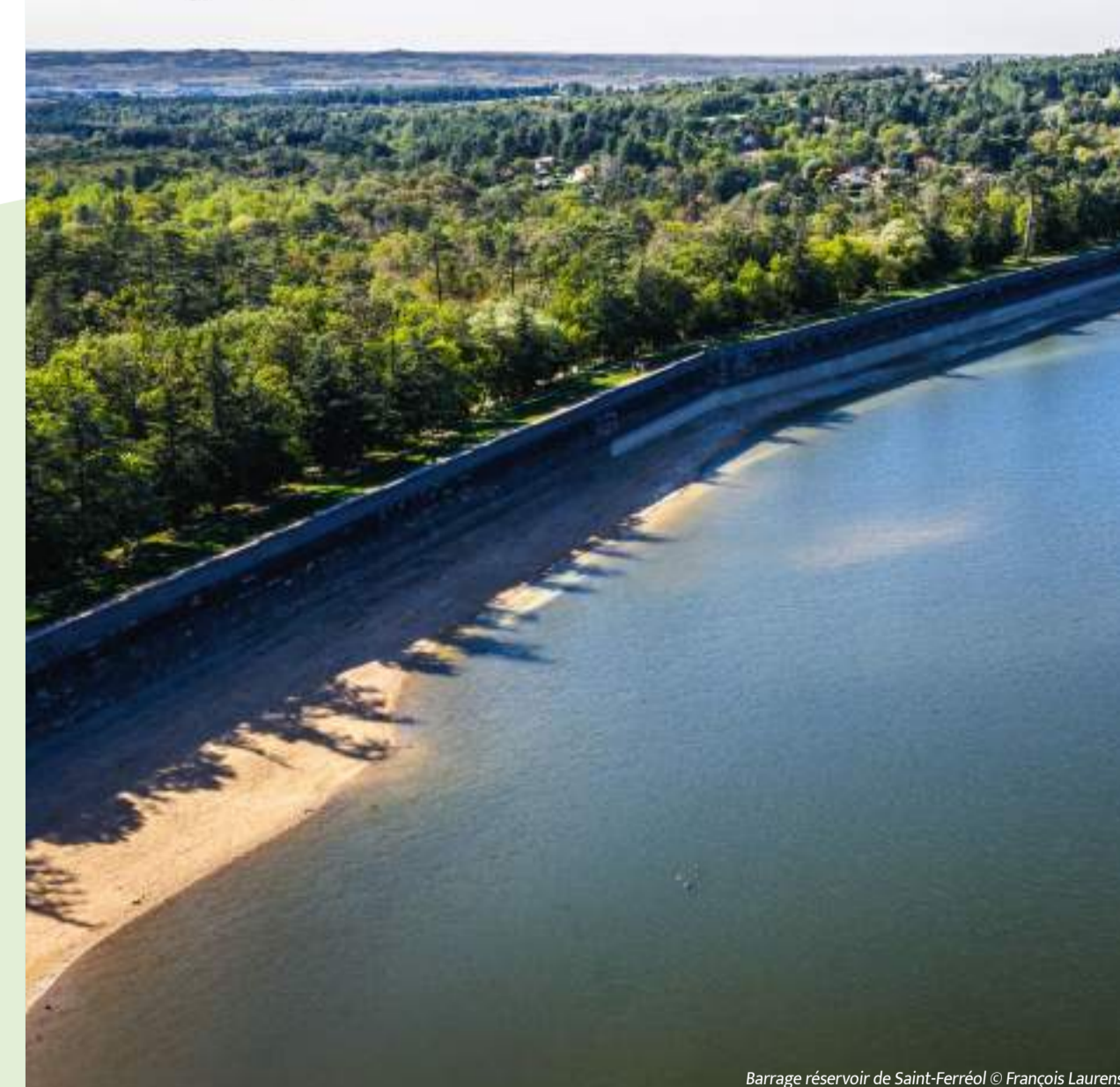
Barrage réservoir de Saint-Ferréol © François Laurens
