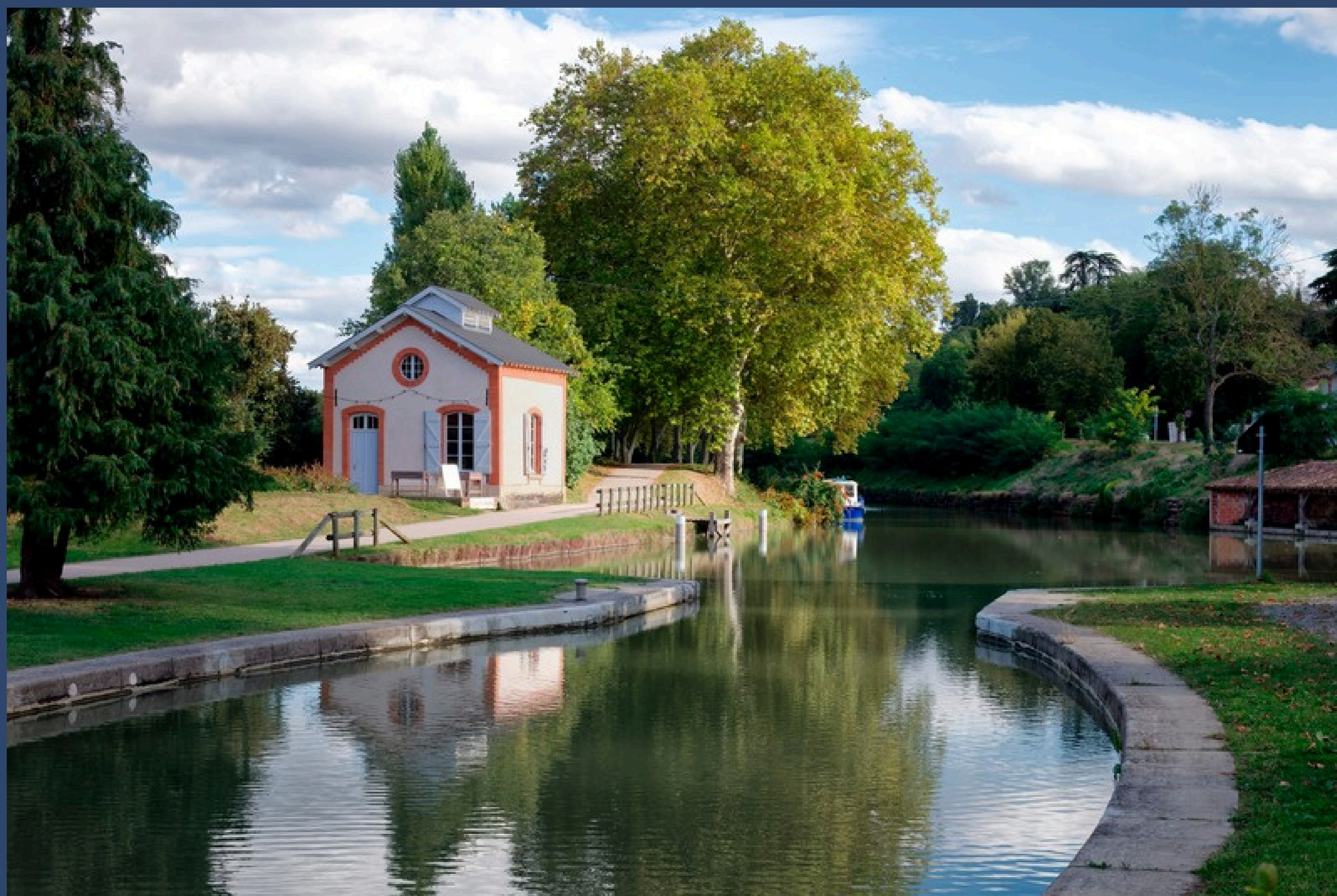
Ecluse de Montgiscard avec l'ancienne station de pompage des Chemins de Fer du Midi (Haute-Garonne)
