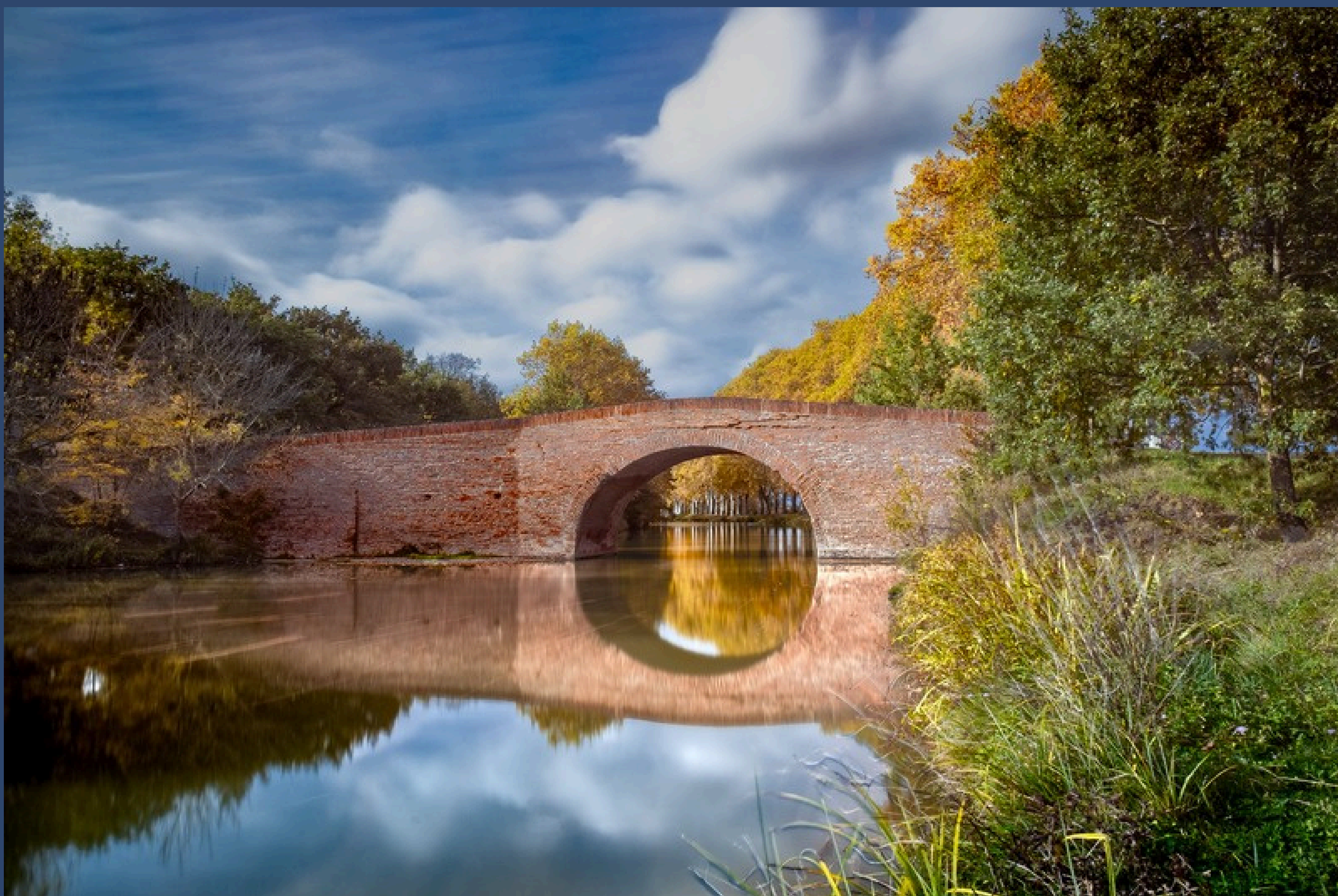
Le pont de Deyme à l'automne (Haute-Garonne)
