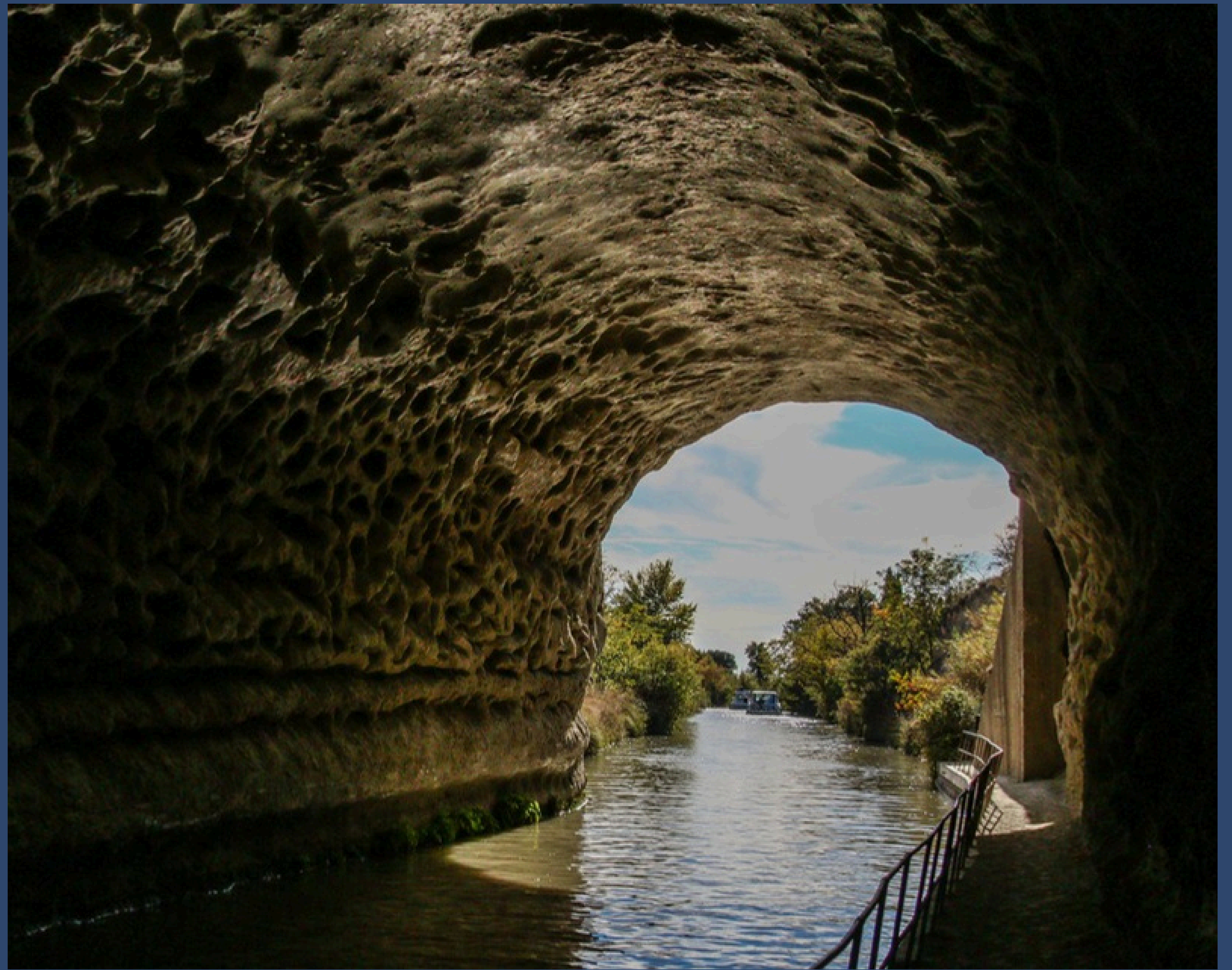
Tunnel du Malpas à Nissan-lez-Enserune (Hérault)
